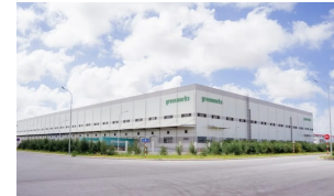
Nhà máy Greenwork Thái Bình Phạm vi: Ống thép cho Hệ thống PCCC
