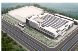
Nhà máy Cooler Master Việt Nam Phạm vi: Ống nhôm cho hệ thống khí nén
