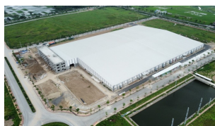
Nhà máy AD Green Solar Phạm vi: Ống thép Airpipe cho hệ thống PCCC
