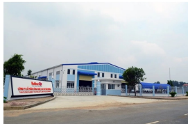
Nhà máy Cao su Thái Dương Phạm vi: Ống thép cho Hệ thống PCCC
