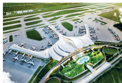
Sân bay Long Thành - Thi công lắp đặt hệ thống ĐHKK/ Thông gió
