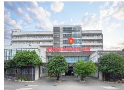
Cung cấp lắp đặt, sửa chữa linh kiện điều hòa Chiller, hệ thống khí sạch phòng mổ.
