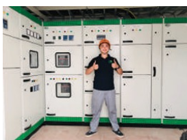
TNR Tower 115 Hưng Đạo
