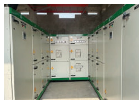
Nhà máy Ngải cầu – KCN Bắc Ninh
