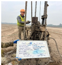
Dự án Nhà máy Seojin
