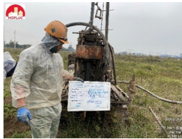
Dự án Nhà máy nhôm Kim Kiều
