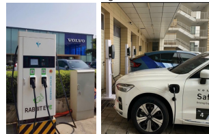
Cung cấp lắp đặt trạm sạc xe ô tô điện
