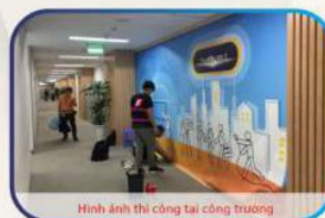
Hình ảnh thi công tại công trường
